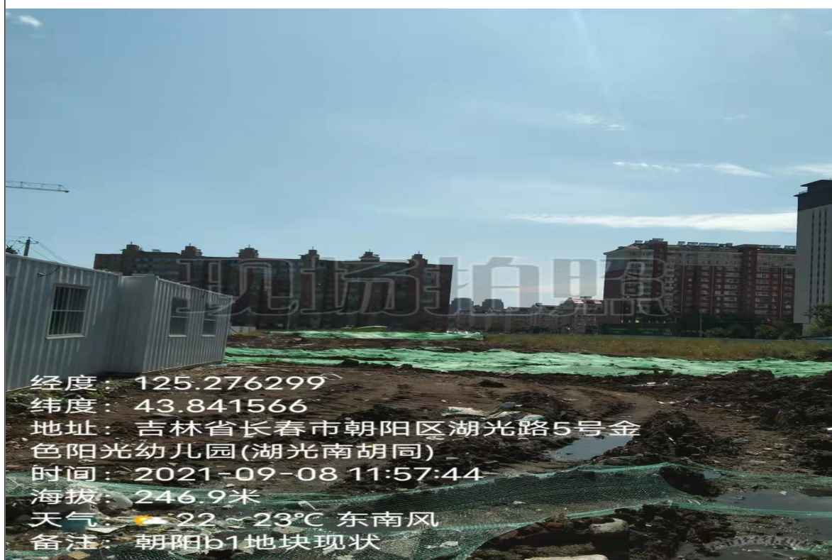
目前地块 B-1 内均未拆除
