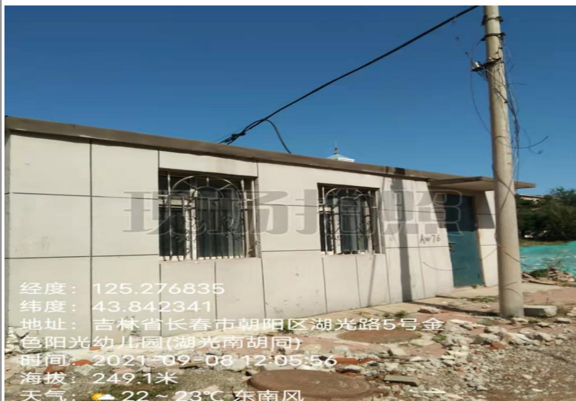
目前地块 A-2 大部分建筑已拆除
