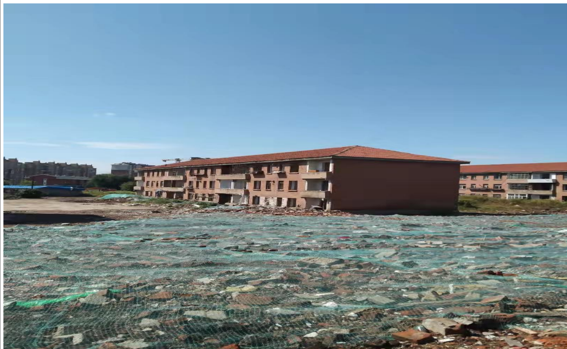
目前地块 A-1 内部分拆除
